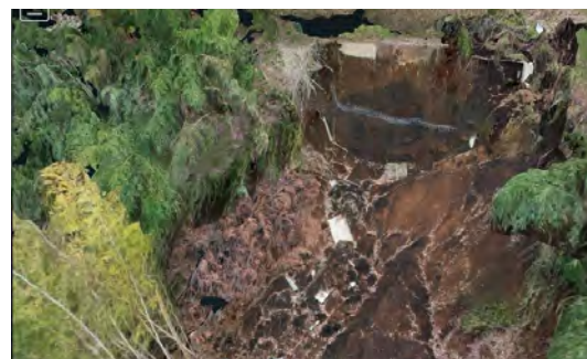
図4 崩壊箇所を空から調査
