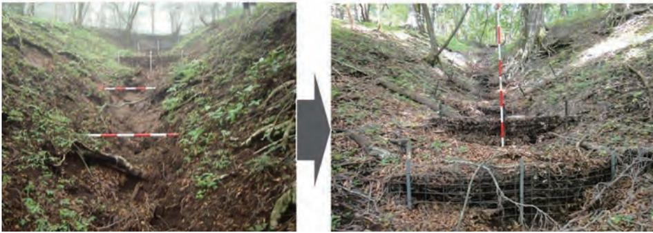
金網筋工では、施工後1～3年程度で20～30cm堆積する箇所が多い
