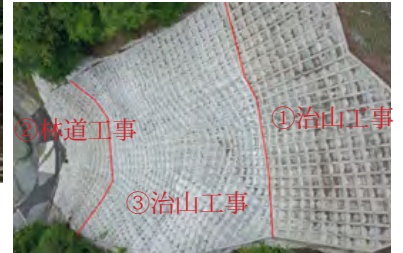
ロックボルト併用した法枠工で崩壊地表面を固定
