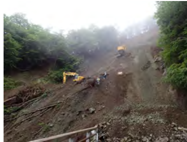
ロッククライミングマシンによる崩壊地の整形
