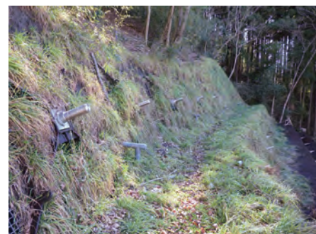
写真4. 復旧工事完成状況 (令和4年12月撮影) 及びグラウンドアンカー工周辺の緑化状況
