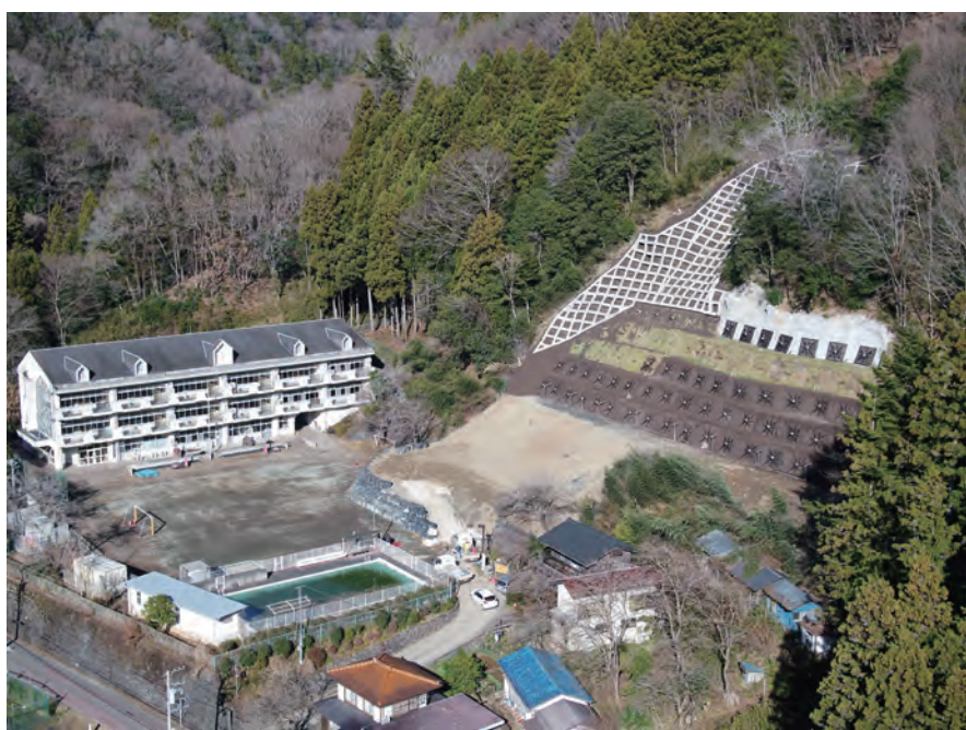
写真4. 復旧工事完成状況 (令和4年12月撮影) 及びグラウンドアンカー工周辺の緑化状況
