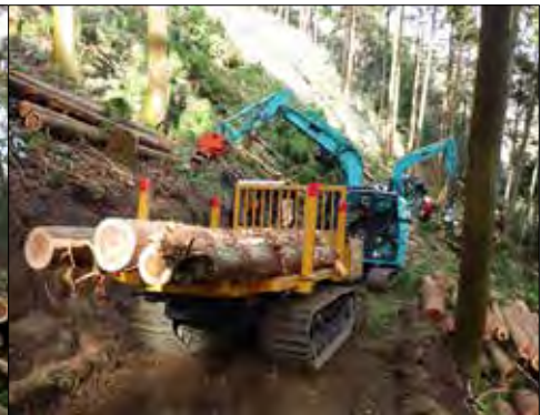
フォワーダで集材・作業路運搬
