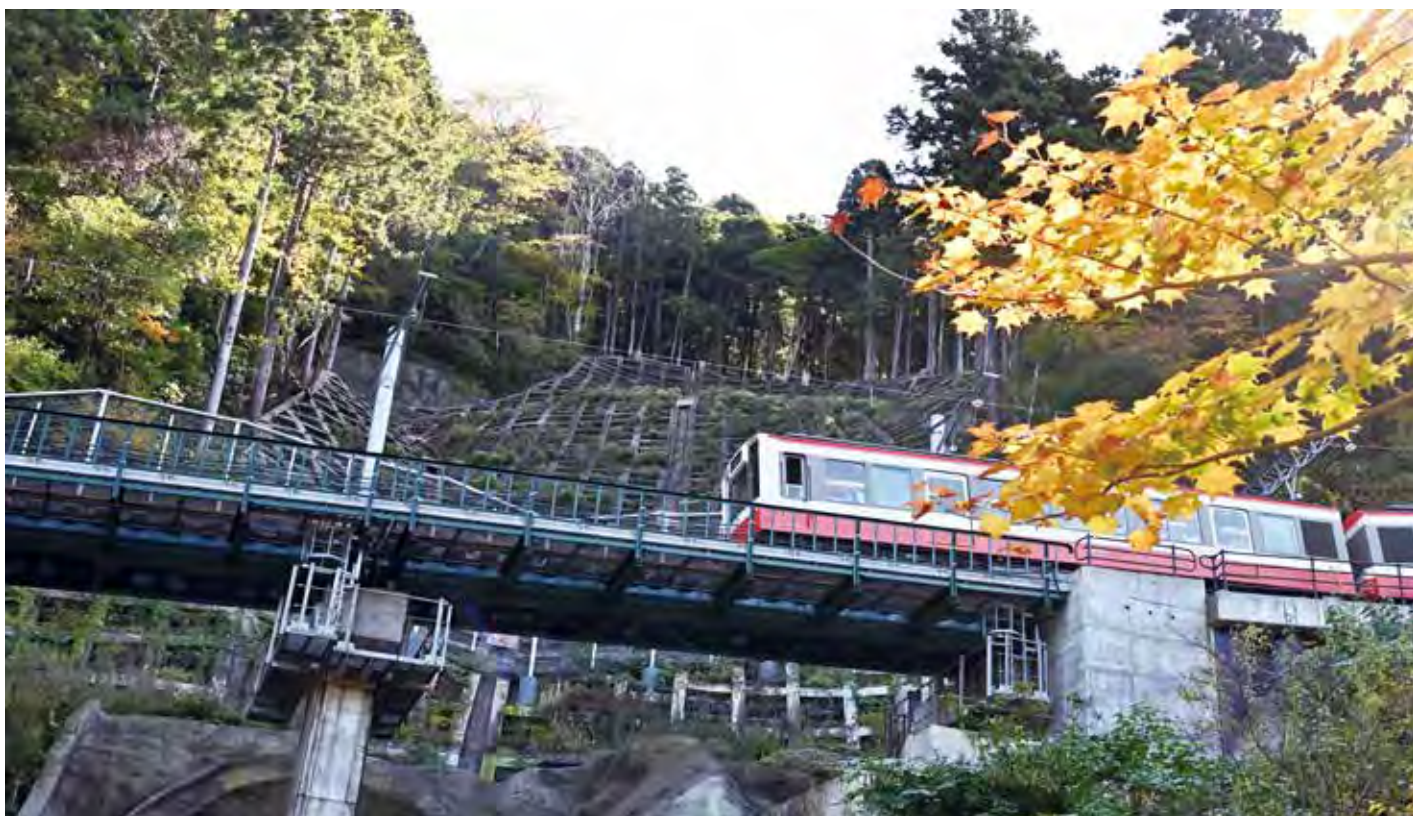
令和元年台風19号被災復旧区間を進行する登山電車（箱根町宮ノ下 蛇骨川下流治山工事）
