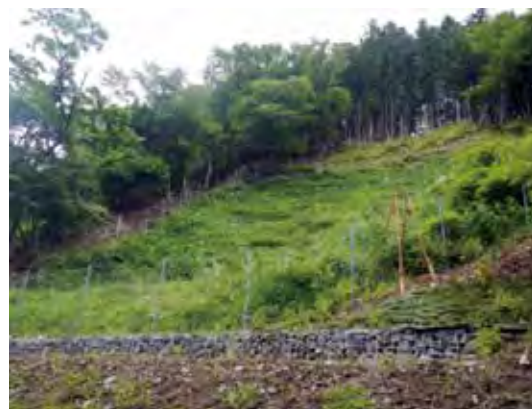
写真1 土木的工法による土壌保全対策
