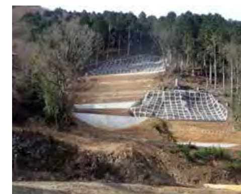
法枠工等による復旧状況
