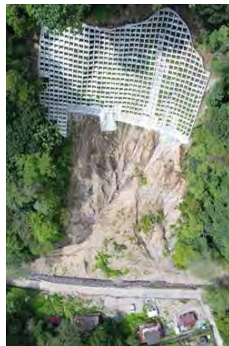
法枠工による復旧状況
