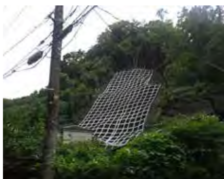
法枠工による復旧状況
